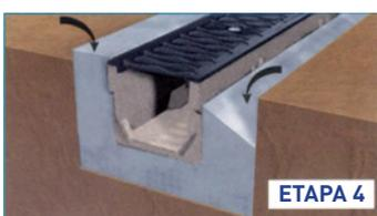
Colocar el hormigón a los lados del canal y realizar el acabado del canal con las capas adyacentes.
