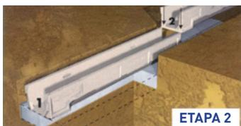
Primero colocar el canal que conectará con la tubería de desagüe y, seguidamente y sobre un lecho de hormigón, colocar el resto de canales.
